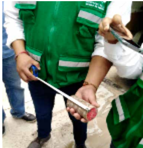
Medición de espesores de núcleos extraídos
