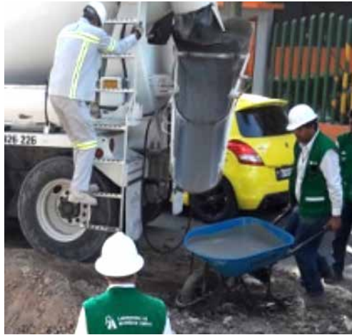
Muestreo de concreto hidráulico
